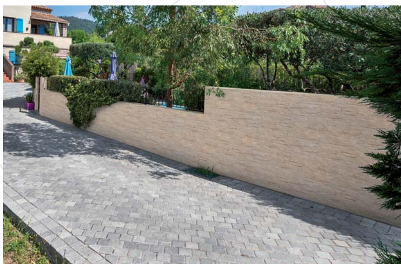
Parement de mur THOLET Aquitaine
